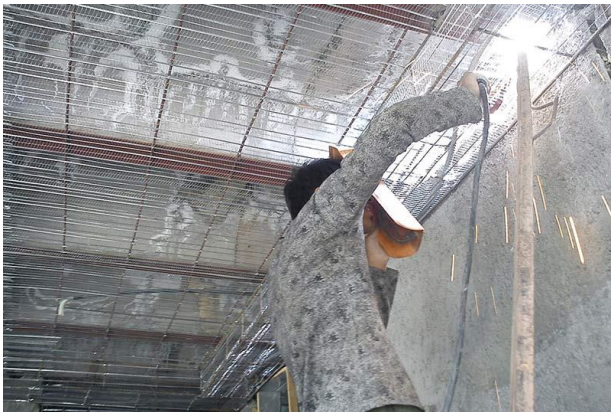
اجرای رابیتس سقف کاذب
