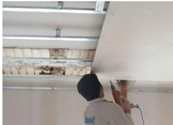
اجرای کناف سقف کاذب
