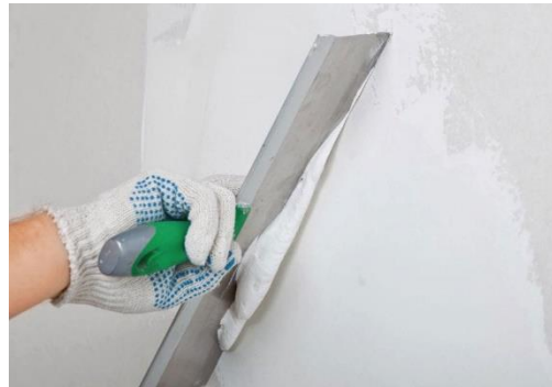
اجرای گچ کشته روی لایه گچ
